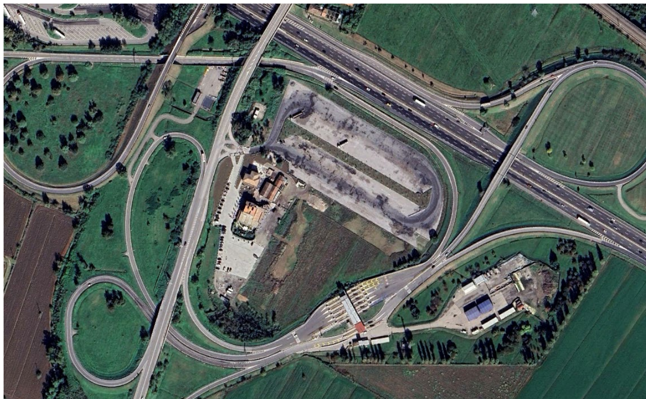
Aree interne uscita autostrada (Veranda)
