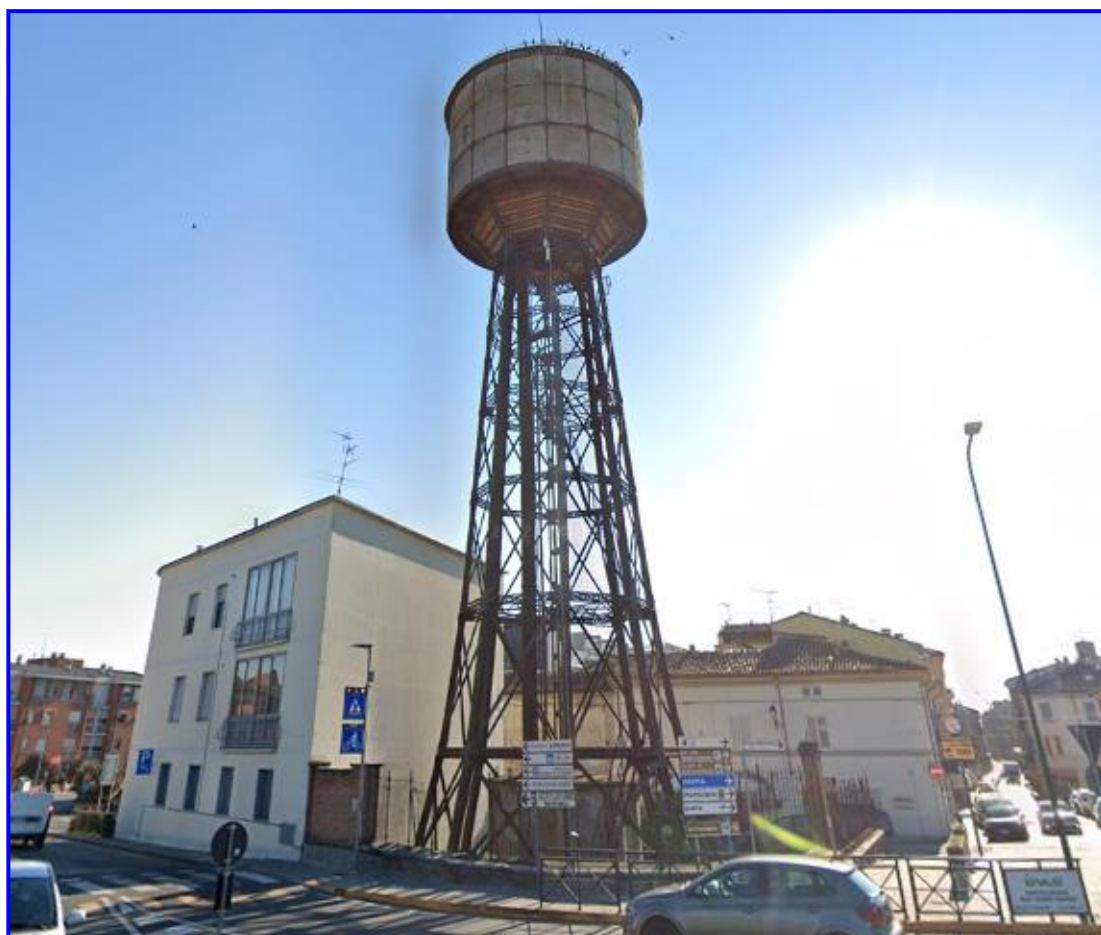
Vista del serbatoio – 55
