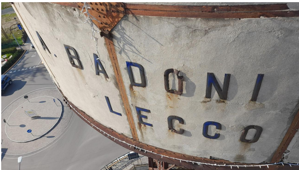
Fig. 8 – Foto rivestimento serbatoio in cls
