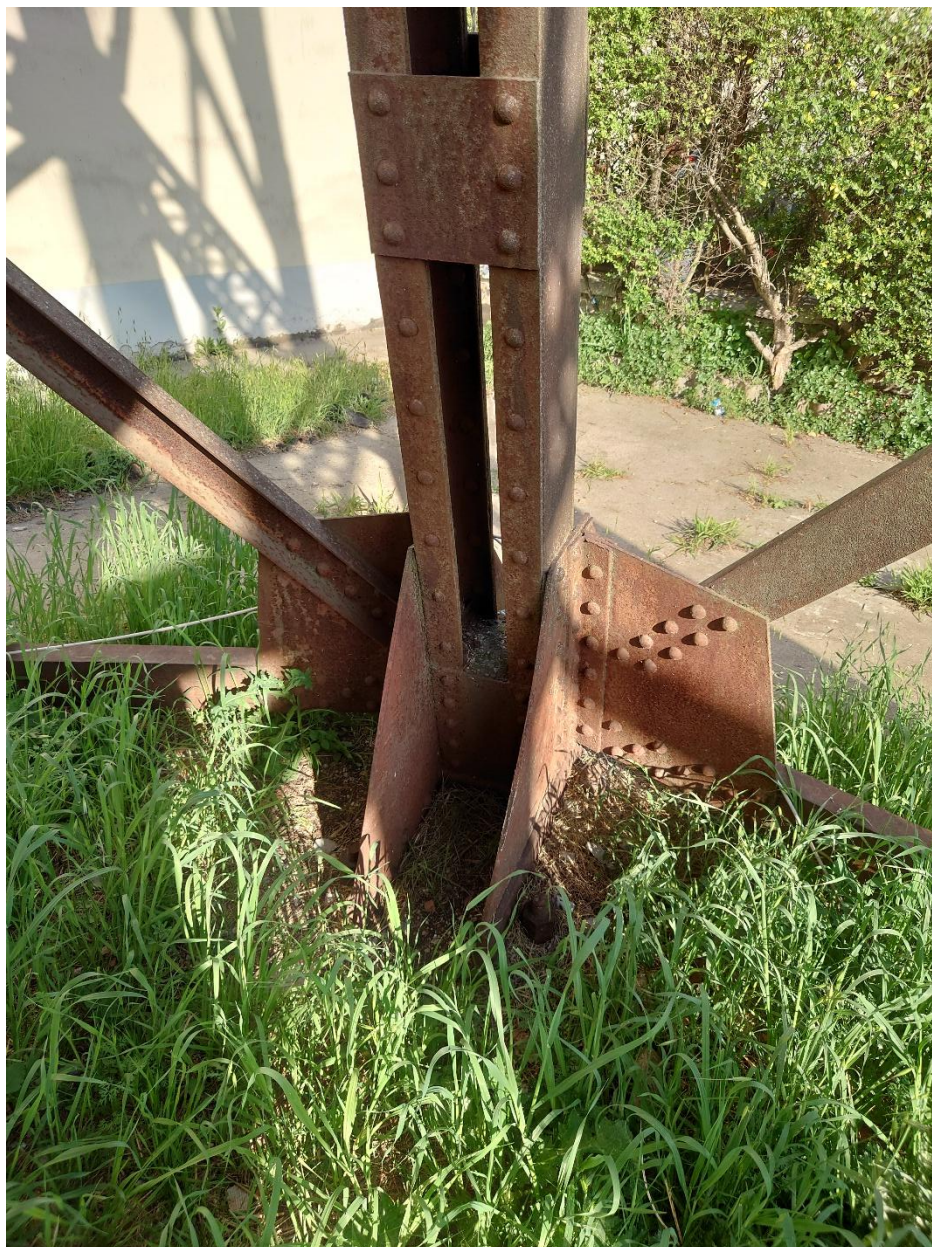
Fig. 13 – Foto dettaglio ancoraggio alla base montanti verticali
