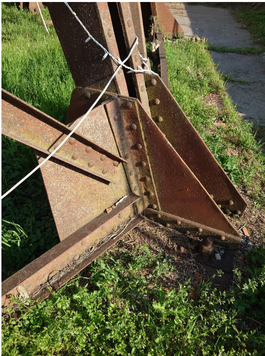
Fig. 14 – Foto dettaglio ancoraggio alla base montanti verticali
