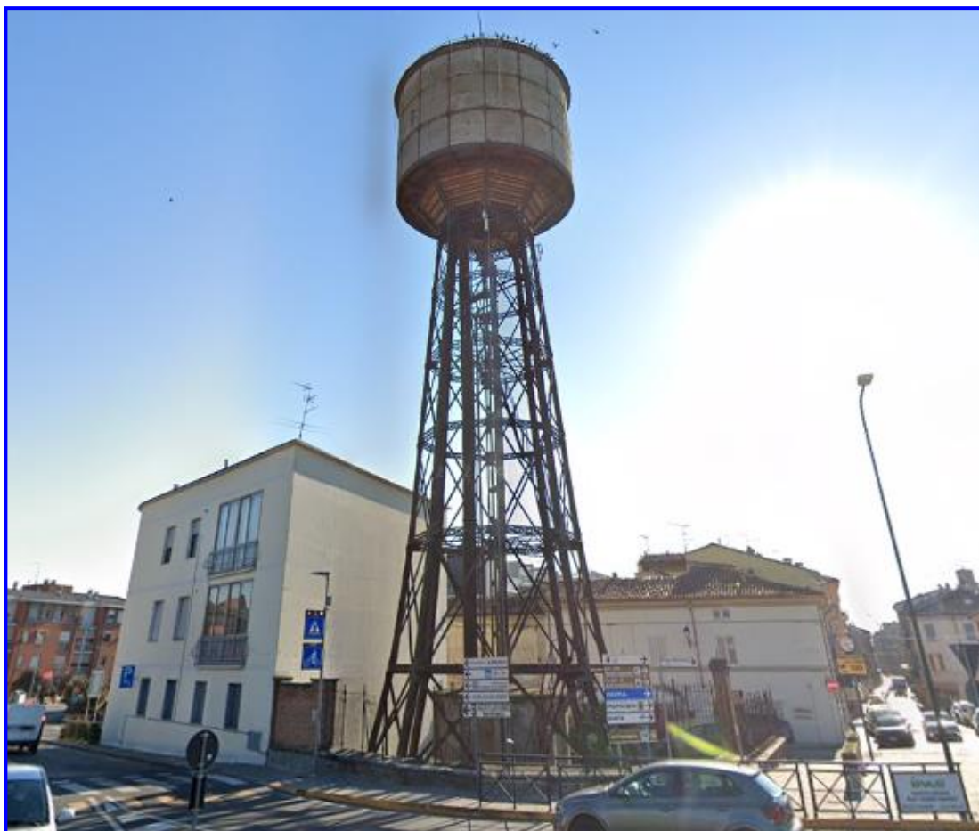
Vista del serbatoio – 55
