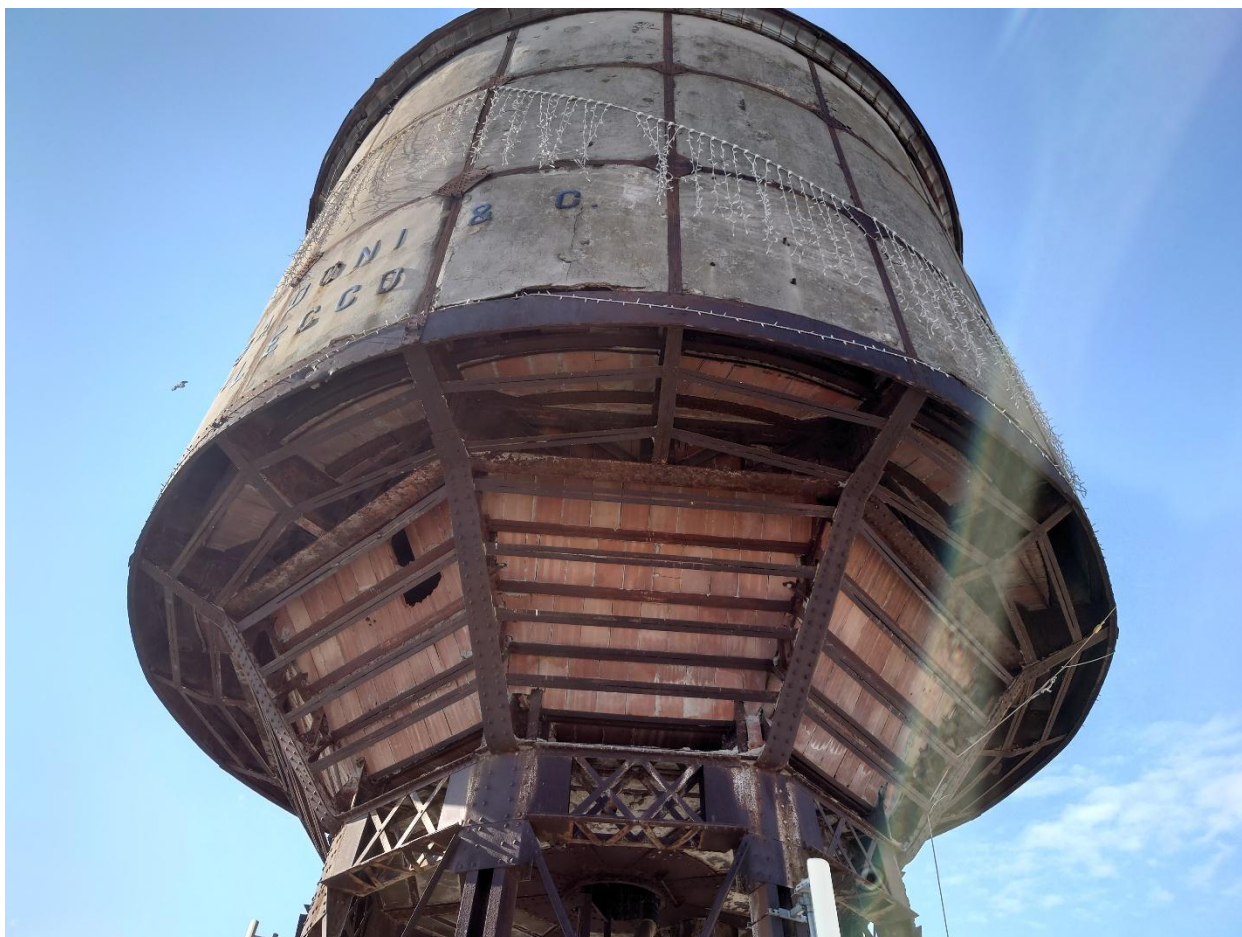
Fig. 7 – Foto intradosso serbatoio
